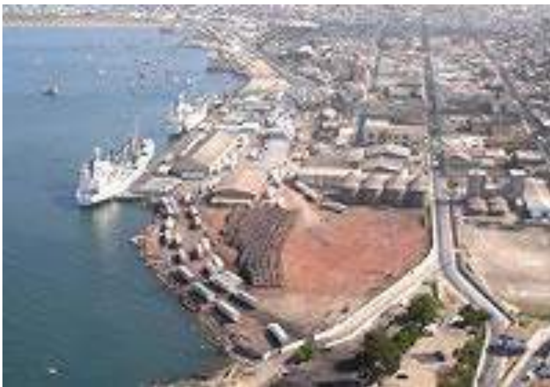
Figura 1.3. Vista Panorámica Puerto y Bahía de Coquimbo
